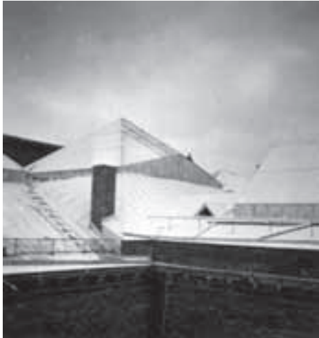
Tik apdengtas stogas ir sudėti švieslangiai
