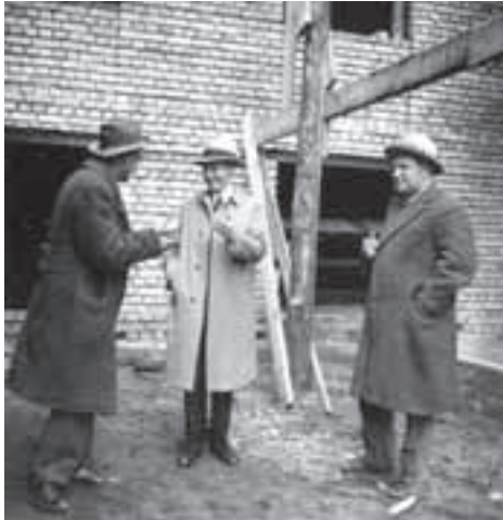
Statybos priežiūrą vykdė inž. archit. Karolis Reisonas (centre). Greta jo (dešinėje) vienas statybos rangovų Dovydas Ilgoskis
