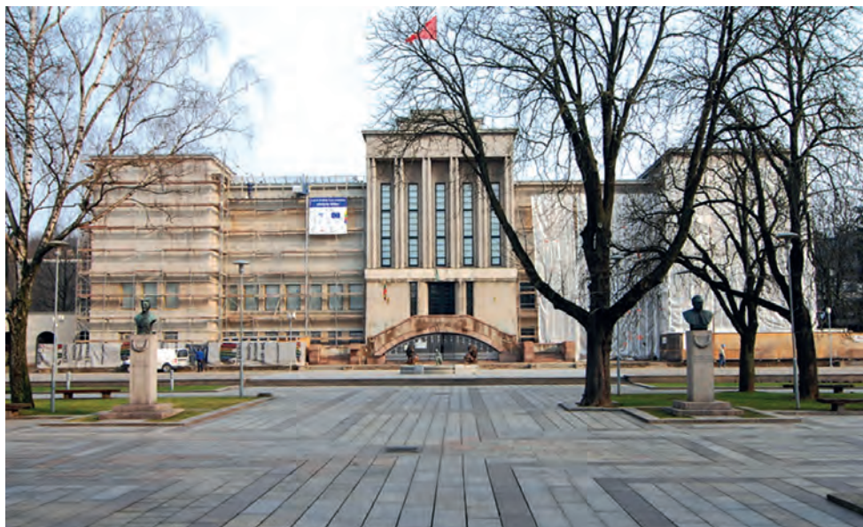
Muziejaus fasadas prieš rekonstrukciją. 2014 m.
