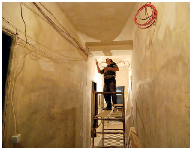
Administracinės muziejaus dalies rekonstrukcijos darbai. 2013 m.
