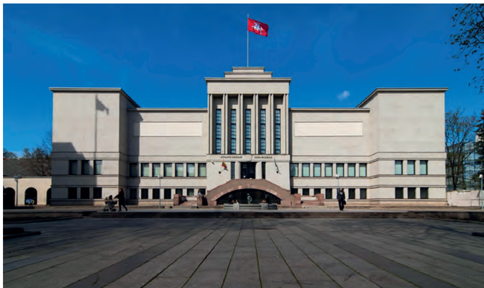
Muziejaus fasadas po rekonstrukcijos. 2015 m.
