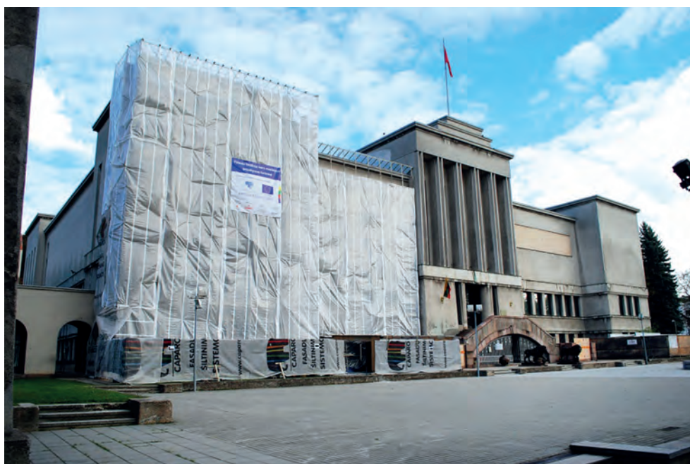
Fasado rekonstrukcijos darbų pradžia. 2013 m.
