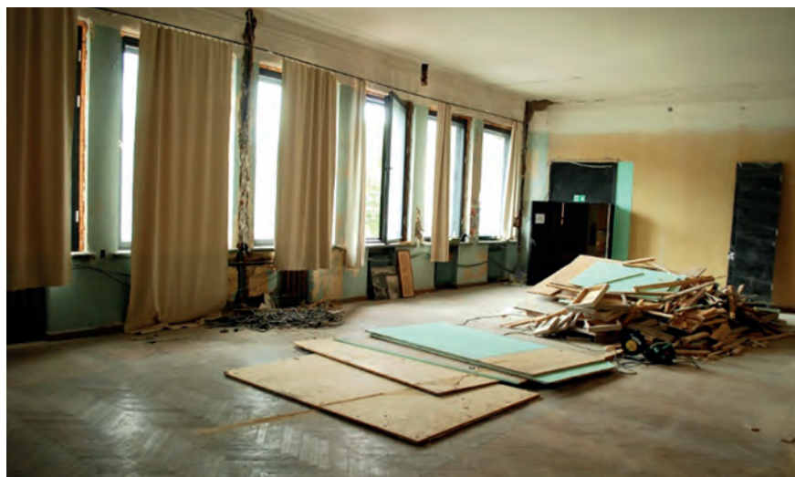
Parodų salė ruošiantis rekonstrukcijai. 2013 m.
