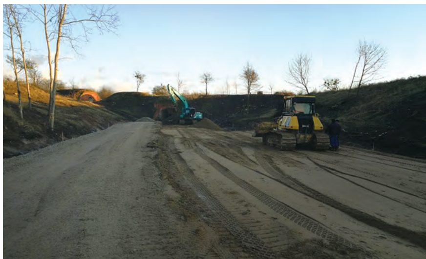
Ekspozicinės aikštelės VI forte įrengimas.
