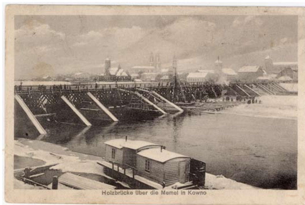
№ 96. Holzbrücke über Memel in Kowno Medinis tiltas per Nemuną, Kaunas Деревянный мост через Нямунас. Каунас
