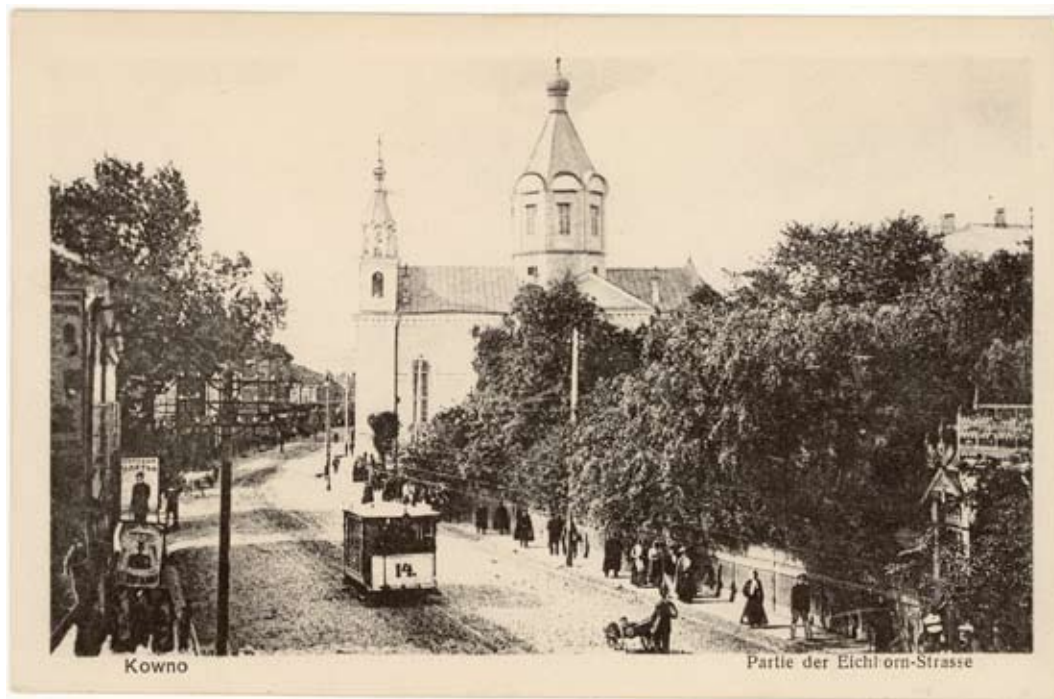
Nr. 120. Kovno. Partie der Eichhorn-Straße Kaunas. Eichborno gatvės fragmentas Каунас. Фрагмент улицы Эйхгорна
