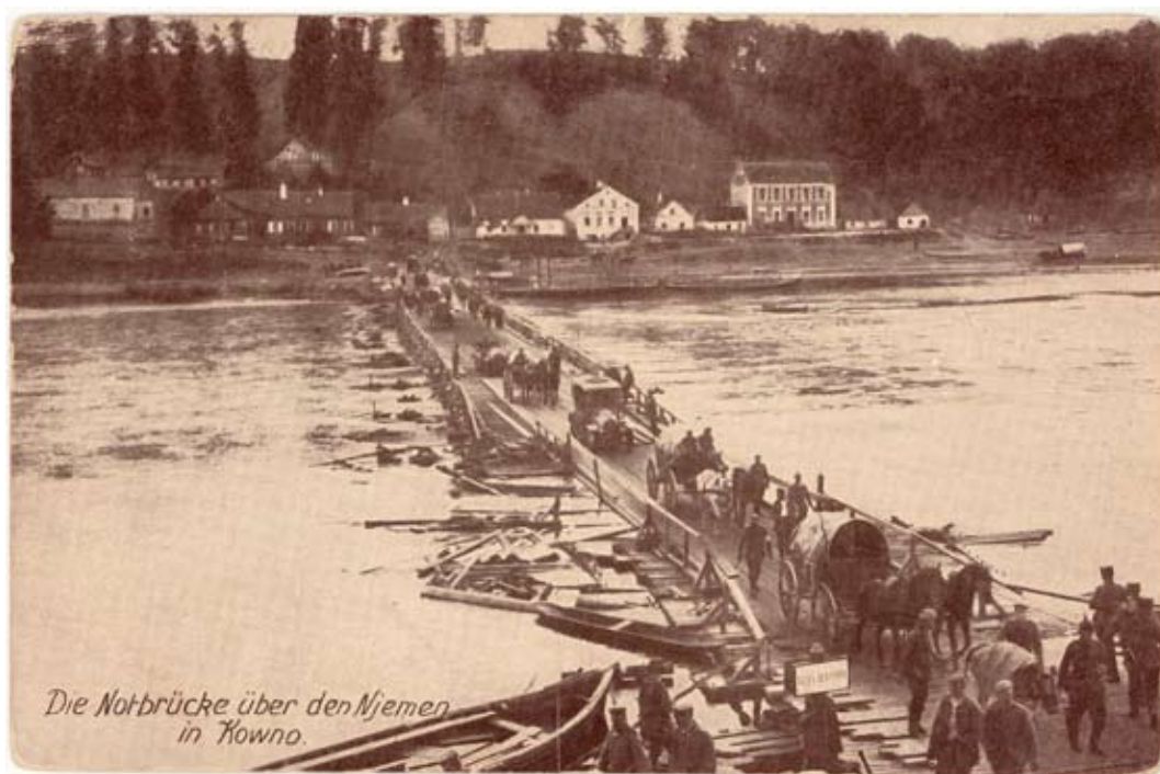
Nr. 43. Die Notbrücke über den Njemen. Laikinas tiltas per Nemuną Временный мост через Нямунас
